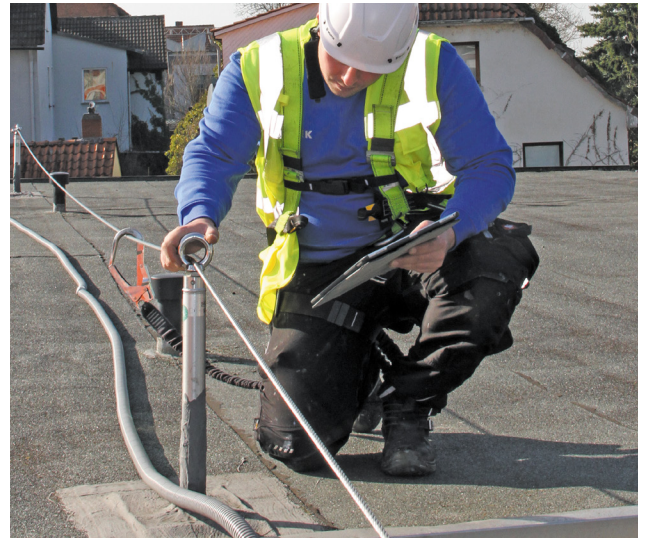
Absturzsicherung (montiert, geprüft, gewartet)
